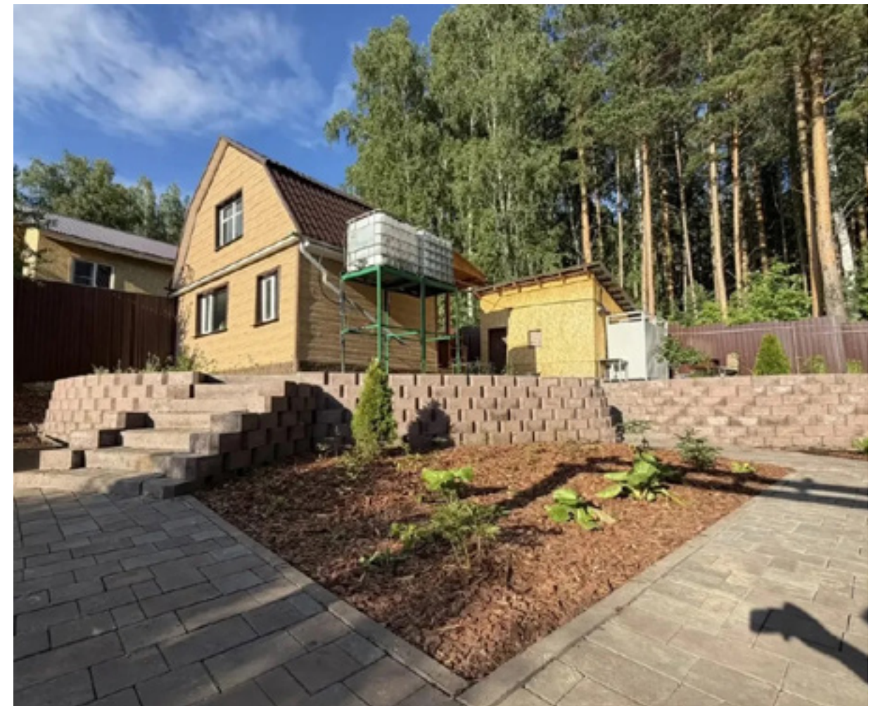
Подпорные стены из блоков 310 мм. Частный дом, г. Екатеринбург
