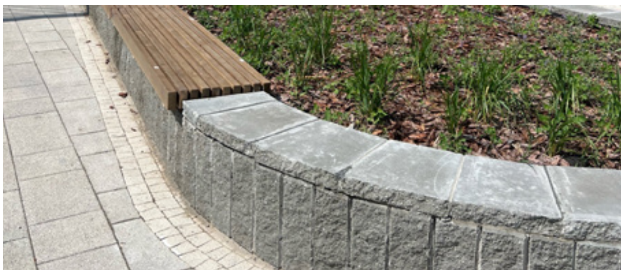
Клумба-скамейка из заборного блока 380x190x140мм и крышки 400x400 мм. ЖК «Мириады», г. Тюмень
