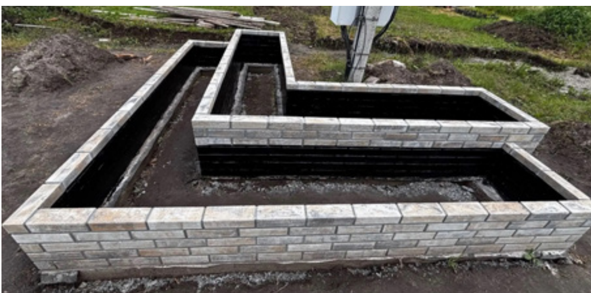
Процесс строительства клумб из вибропрессованного кирпича
