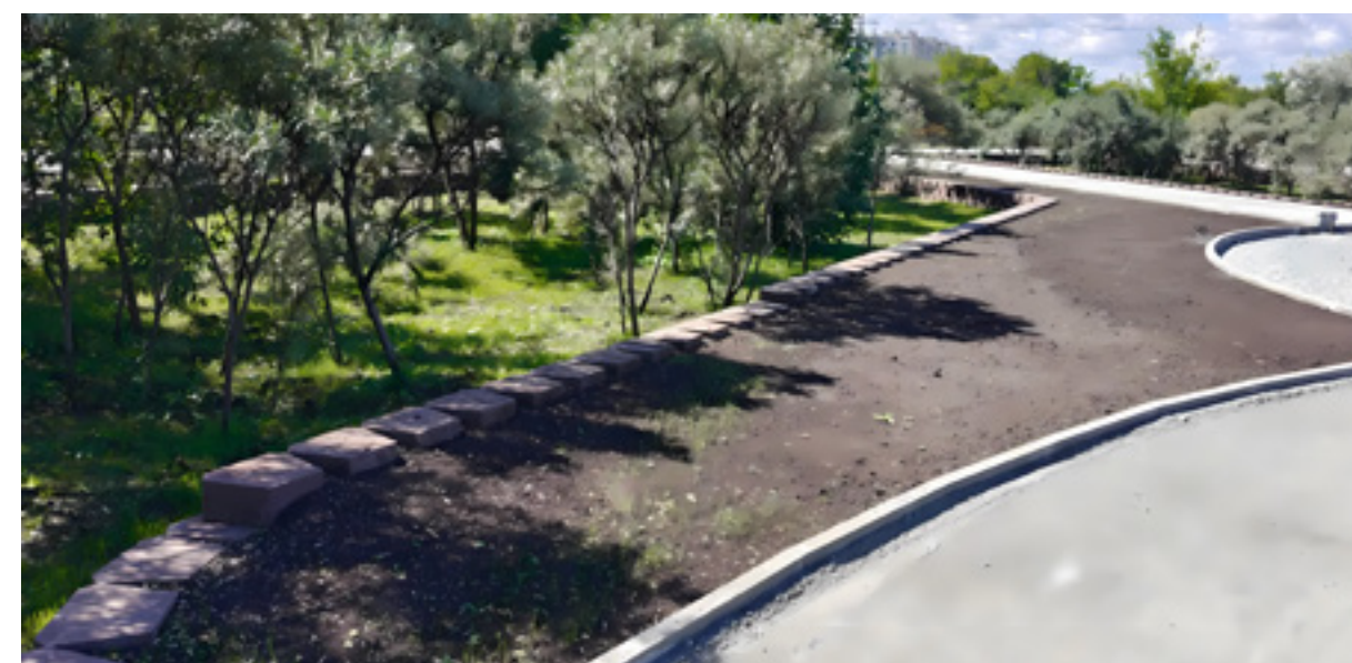
Подпорная стена из блоков шириной 310 мм. Парк «Плодушка», г. Челябинск
