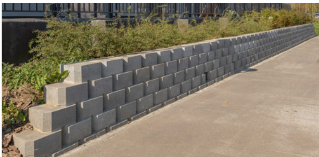
Процесс возведения подпорных стен из блоков шириной 310 мм. Частный дом, г. Казань, и ЖК «Ритмы», г. Тюмень
