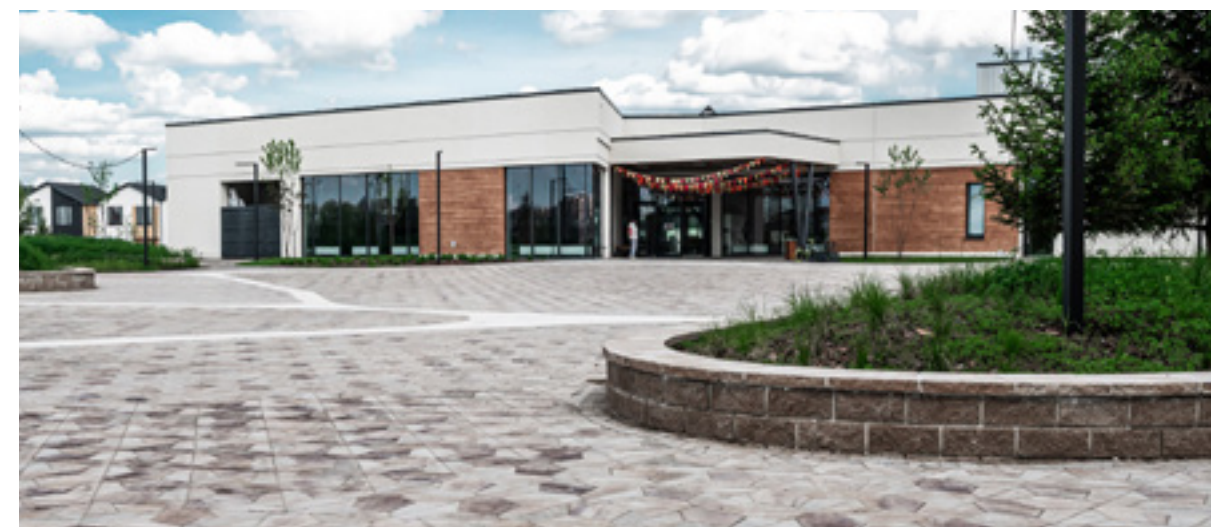
Клумба из заборного блока 380x190x140мм и крышки 400x400 мм. ЖК «Ритмы», г. Тюмень
