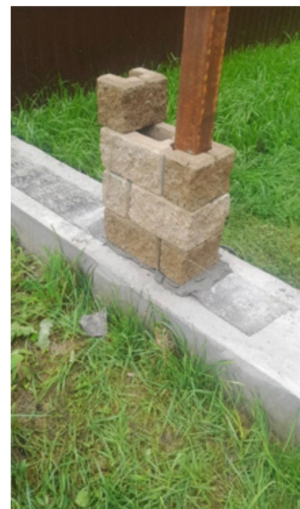
Комбинированный забор из заборных блоков: 260x190x140, 120x190x140; 380x190x140 и крышки 500x220. Частный дом, г. Тюмень
