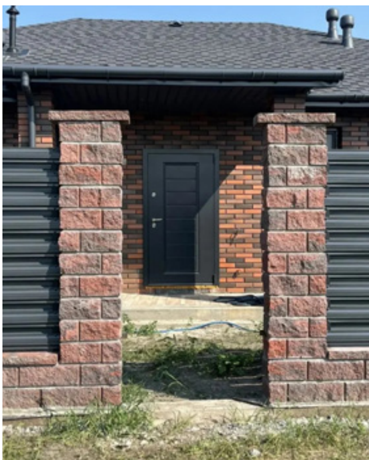
Комбинированный забор из заборных блоков: 260x190x140, 120x190x140; 380x190x140 и крышки 500x220. Частный дом, г. Тюмень
