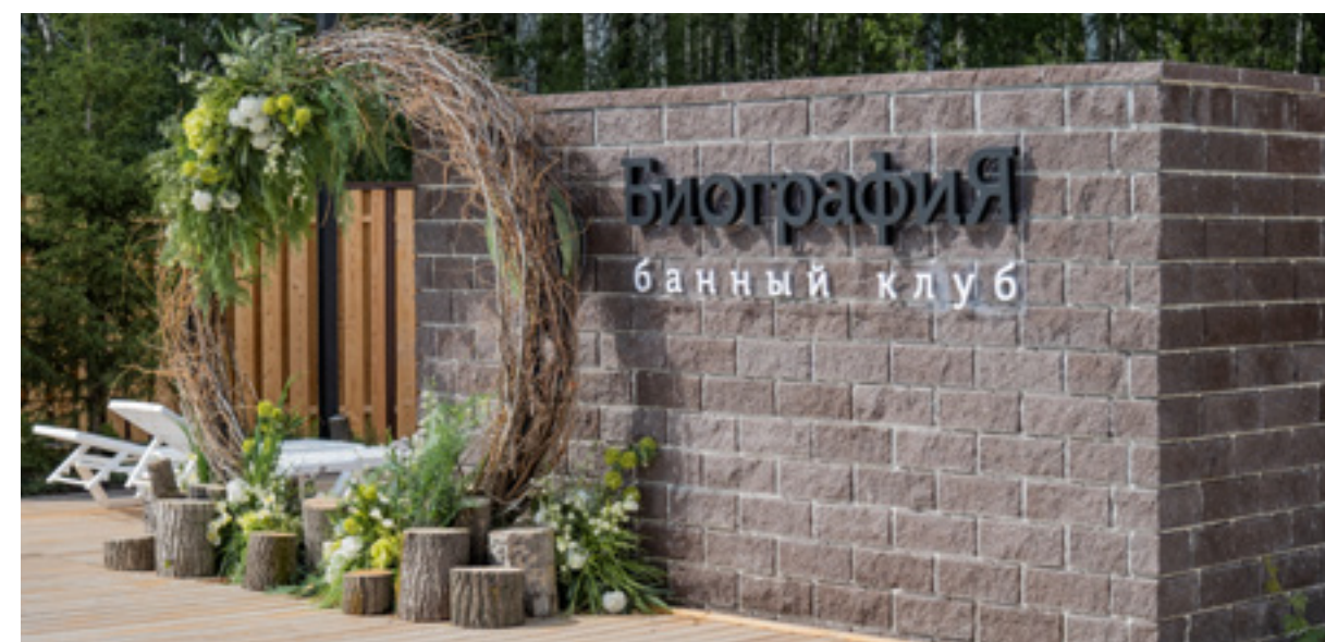
Подпорная стена из заборных блоков: 380x190x140, 260x190x140; 120x190x140 и крышки 500x220. г. Тюмень
