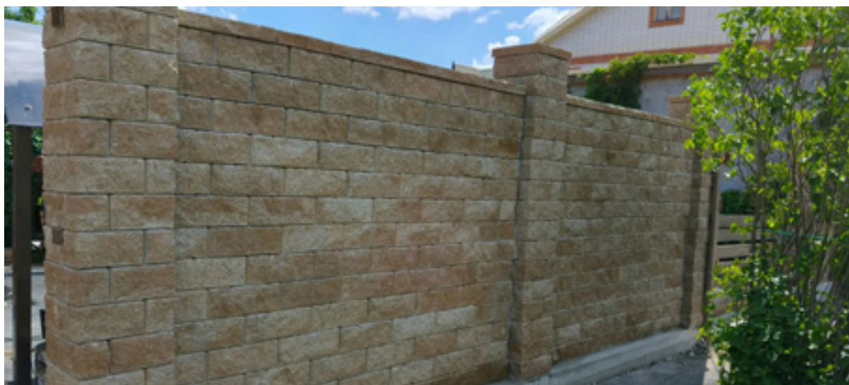
Процесс возведения глухого забора из заборных блоков: 380x260x140, 380x120x140; 380x190x140 и крышки 400x400. Частный дом, г. Тюмень
