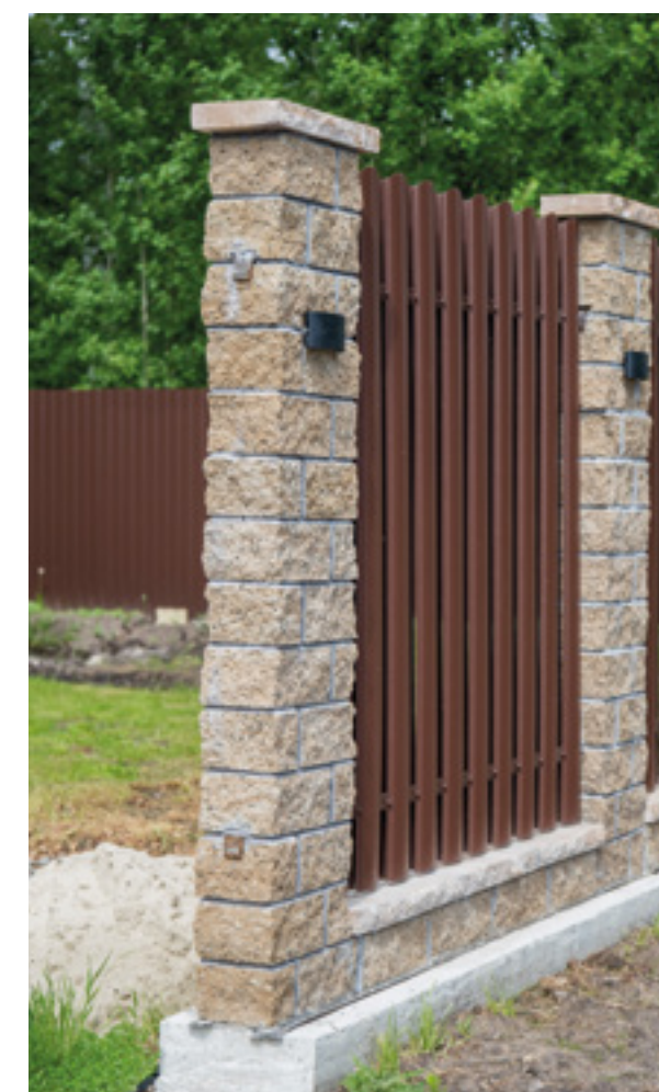
Комбинированный забор из заборных блоков: 260x190x140, 120x190x140; 380x190x140 и крышки 500x220. Частный дом, г. Тюмень
